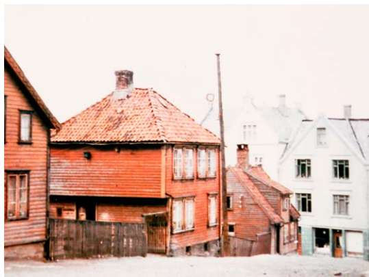
Huset til venstre er revet, men hadde på 1950-tallet adresse Øvre Blåsenborg. De to nederste husene har adresse Pedersgata 14 og 16.
