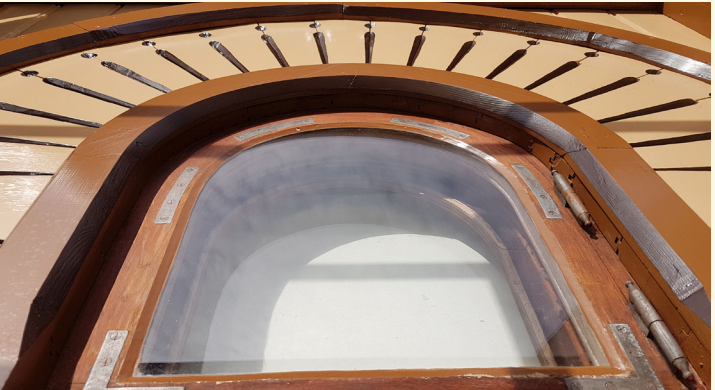
Nå har alle malingslagene blitt fjernet på flere av veggene, og huset har fått tilbake sine opprinnelige farger og detaljer – i linoljemaling. Foto: Mathies Ekelund Erlandsen.
